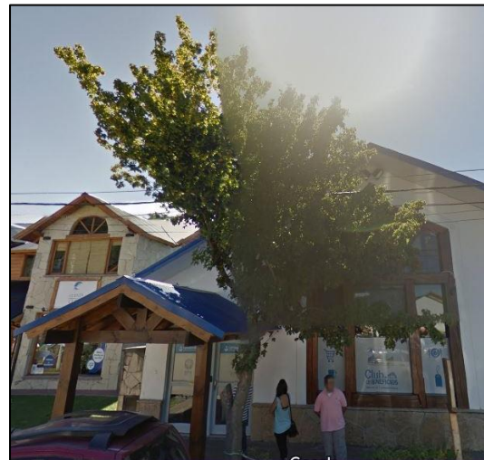
Figura 33: Usuarios haciendo fila para ingresar al cajero automático. Imagen de Google Street View feb. 2014.
