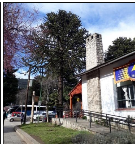
Figura 42: Vista desde la calle Tte. Cnel. Pérez.
